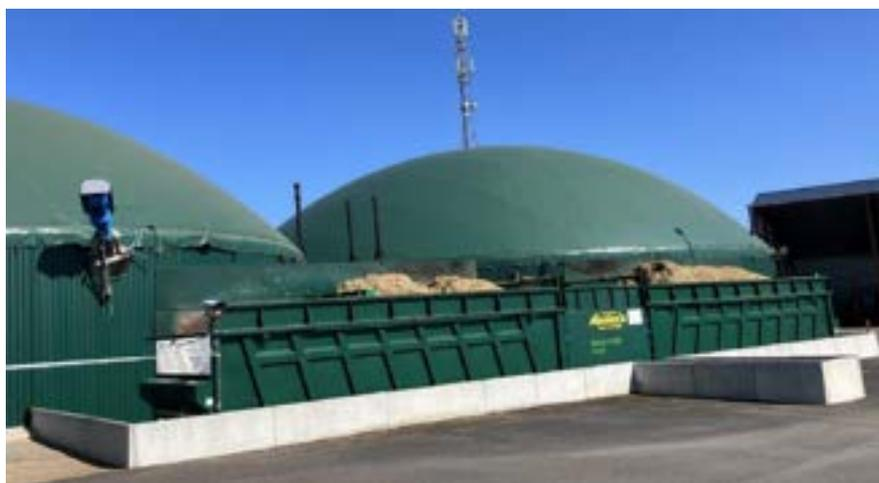
La trémie pour l'incorporation des matières solides est équipée d'une vis mélangeuse équipée de couteaux d'une puissance de 22 kW. Le broyeur-mélangeur Premix permet d'obtenir une matière plus fine dont la fermentation sera améliorée.
